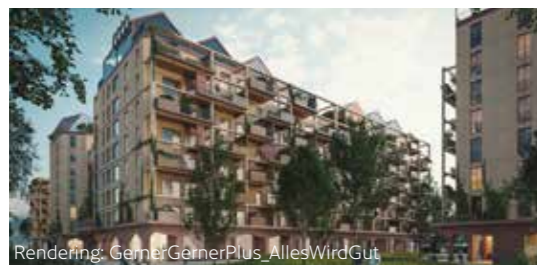
Rote Emma: Gemeinsam mit MIGRA entsteht bis 2025 ein Holz-Hybrid-Wohnbau mit einer Urban-Farming-Dachlandschaft.
