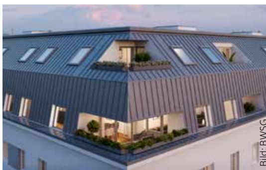
Die Wohnanlage in der Drieschützgasse im elften Wiener Gemeindebezirk wurde bis ins Dachgeschoss heizkostensparend neu gedämmt. Balkone wurden ebenfalls angebaut.
