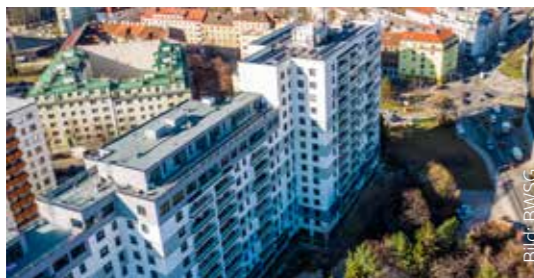
In der Hauffgasse 37–47 (1110 Wien) entstanden im Zuge einer thermischen Sanierung 79 zusätzliche Mietwohnungen.
