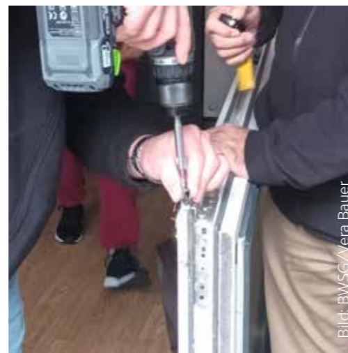
Gewusst wie: Da hat jemand den Dreh raus – schon schließt die Balkontür wieder perfekt. Bei alten Fenstern werden Beschlagteile unterschiedlich kombiniert. Was nicht passt, wird passend gemacht.
