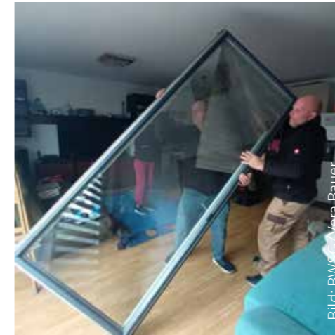
Innerhalb von 15 Minuten wurde die Balkontür ausgehebelt, ein neues Eckband angeschraubt und die Tür wieder eingehängt.
