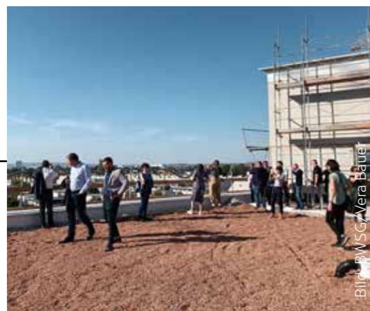
Die freifinanzierten Eigentumswohnungen „Gretls Garten“ sollen bis Herbst 2024 fertiggestellt werden.
